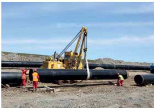
Рабочие прокладывают нефтепровод
